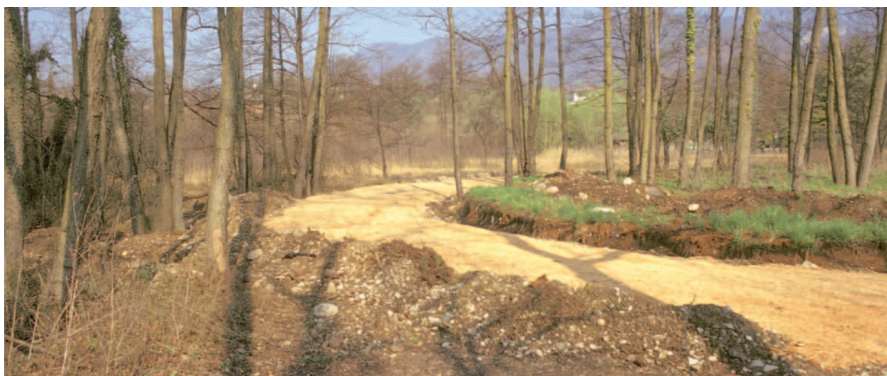
22. Zona umida di Colombaro. Primavera 2005: strada in fase di realizzazione nel bosco igrofilo.
