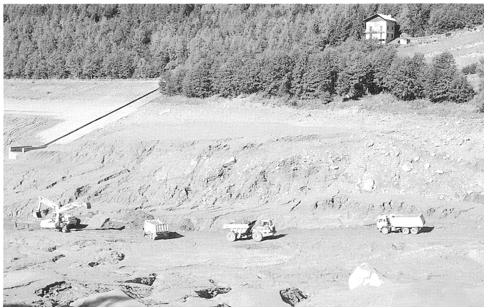
Fig. 5 - Operazioni di rimozione meccanica del sedimento accumulato.
