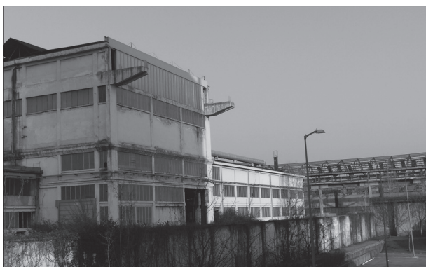
Fig. 14 - Zona industriale dismessa tra Via Orzinuovi e Via Dalmazia
