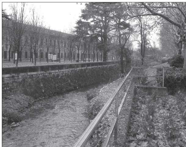
Fig. 23 - Torrente Garza nei pressi di Via Leonardo da Vinci
